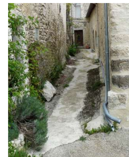
RUISELLEMENT DES EAUX PLUVIALES ENTRAÎNANT GRAVIER ET SABLE, EFFET DE SEUIL INSUFFISANT, FORTE VITESSE, ALTÉRANT LES BORDS DE FAÇADE EN FACE
