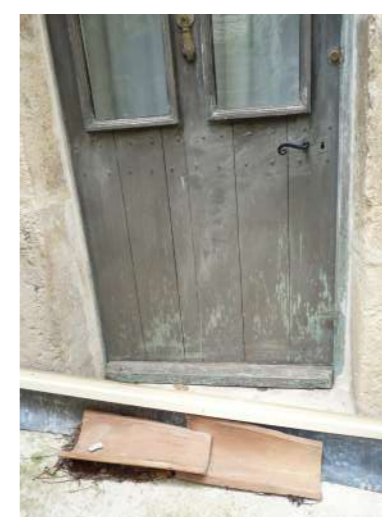
RUISELLEMENT DES EAUX PLUVIALES ENTRAÎNANT GRAVIER ET SABLE, EFFET DE SEUIL INSUFFISANT, FORTE VITESSE, ALTÉRANT LES BORDS DE FAÇADE EN FACE
