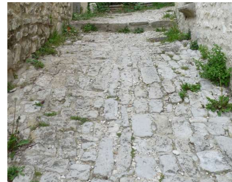
RAVINEMENT ET DÉPÔTS DE GRAVIER ET SABLE EN AVAL, DÛ À LA VITESSE DE L'ÉCOULEMENT ET AU MATÉRIAU PEU STABLE
