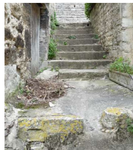
RUISELLEMENT DES EAUX PLUVIALES ENTRAÎNANT GRAVIER ET SABLE, EFFET DE SEUIL INSUFFISANT, FORTE VITESSE, ALTÉRANT LES BORDS DE FAÇADE EN FACE
