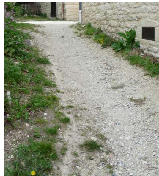
RAVINEMENT ET DÉPÔTS DE GRAVIER ET SABLE EN AVAL, DÛ À LA VITESSE DE L'ÉCOULEMENT ET AU MATÉRIAU PEU STABLE
